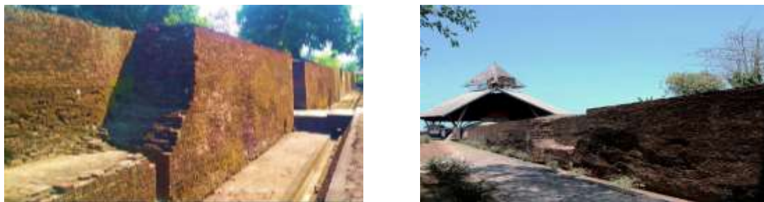
Gambar 9. Struktur dinding Benteng Somba Opu
