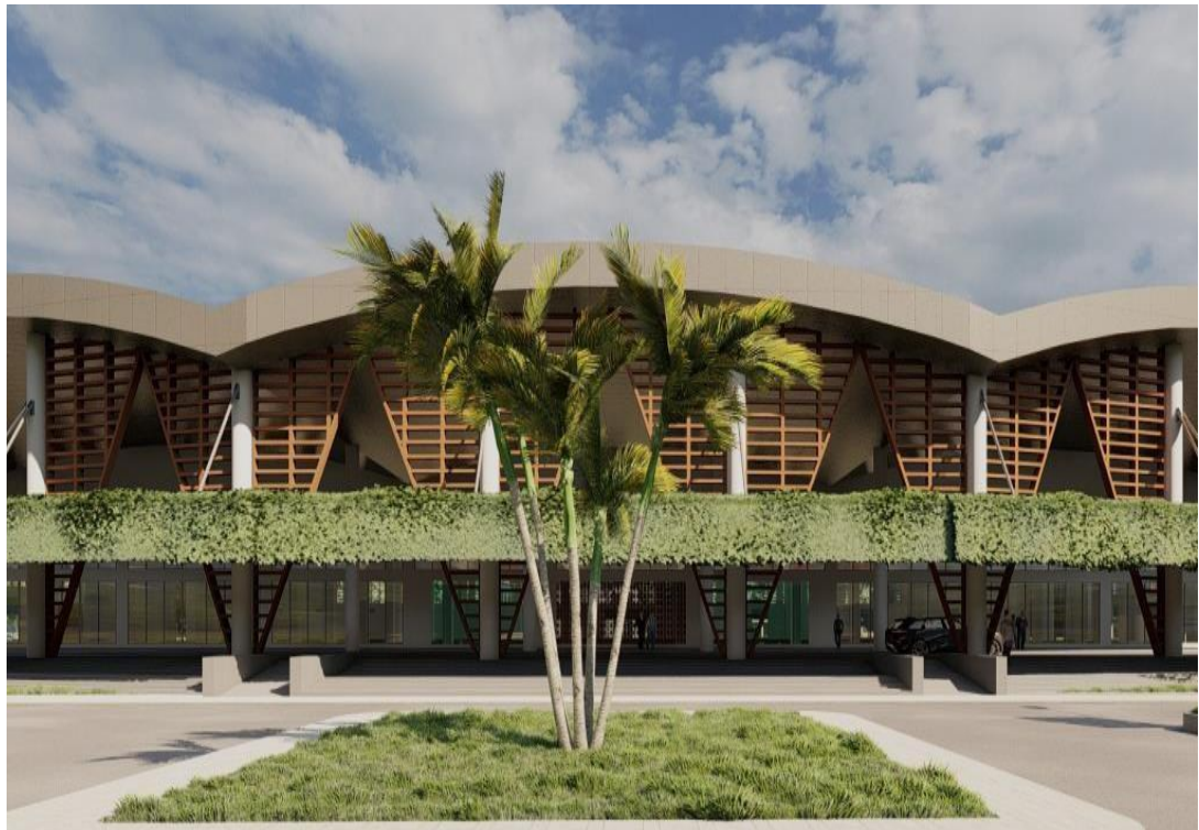
Gambar 7: Penerapan Material Kayu Pada Fasad Bangunan
