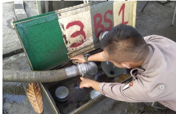
Gambar 2. Proses Pengisian Minyak pada Tangki Timbun
