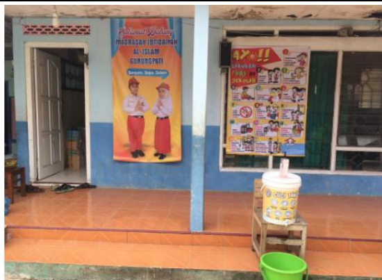
Gambar 1. Kondisi Keran Cuci Tangan di Depan Kelas
