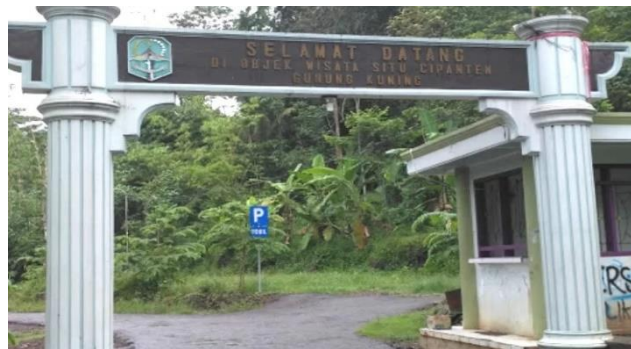
Gambar 6. Kondisi jalan menuju kawasan Situ Cipanten
