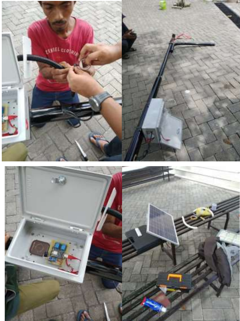
Gambar 4. Pemasangan Box Mikrokontroller, Lampu dan Panel Surya ke Tiang PDU
