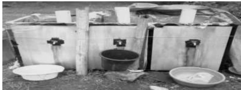
**Gambar 3.** Sumur Resapan yang menggunakan sekat antar sumur
