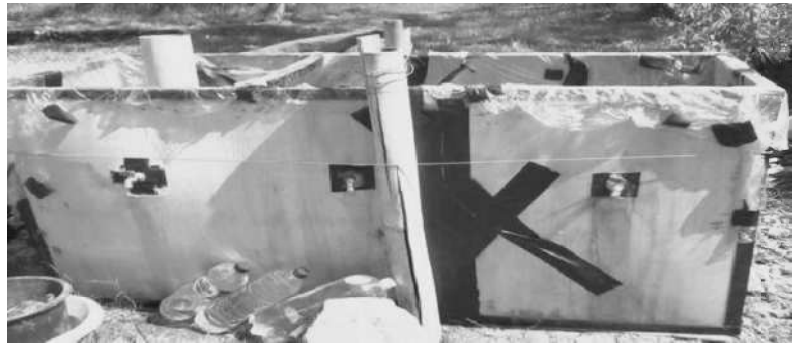
Gambar 4. Sumur Resapan yang tanpa sekat antar sumur
