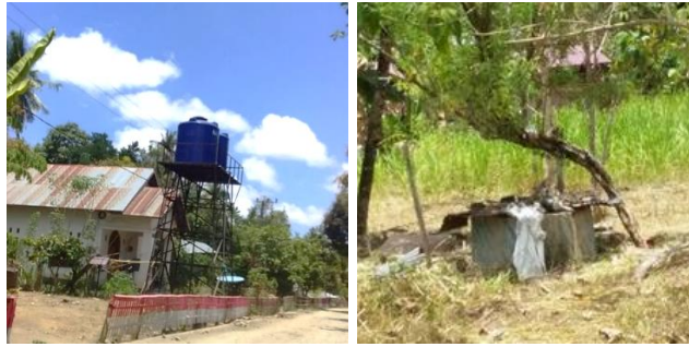
Gambar 11 Penyediaan Air Bersih Desa Pasaka
