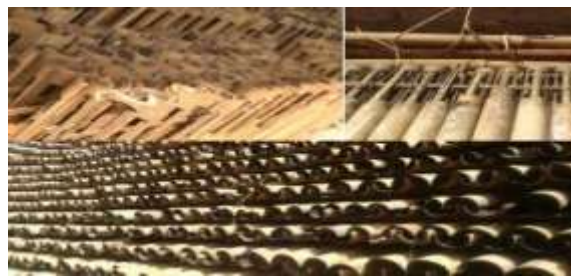
Gambar 10. Proses Penyambungan Bambu pada Bagian Penutup Atap Sumber : Dokumentasi, 2017
