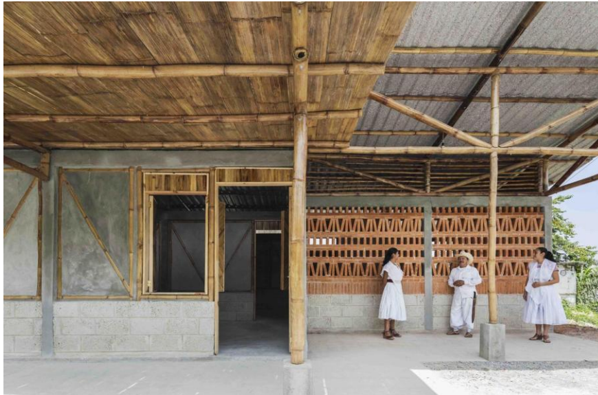
Gambar 9. Konfigurasi material sebagai bentuk arsitektur yang tidak terkondisi dalam menciptakan lingkungan yang terkondisi secara suhu dan kondisi gempa
