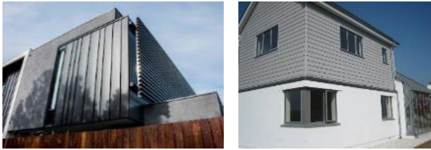
Gambar 2. Fasad dengan metal cladding
