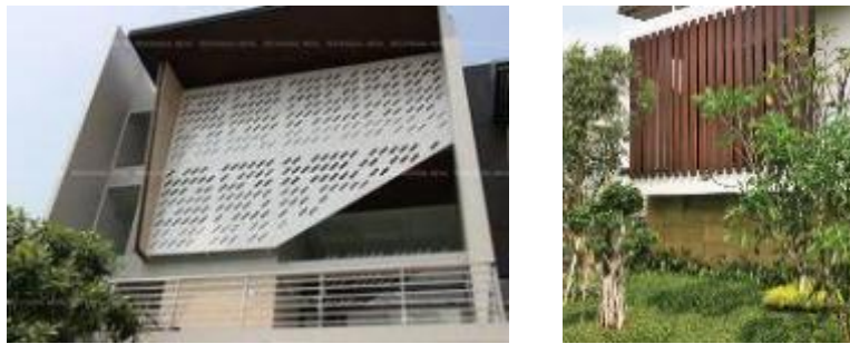
Gambar 4. Bangunan Dengan Secondary Skin Sumber: https://idea.grid.id/
