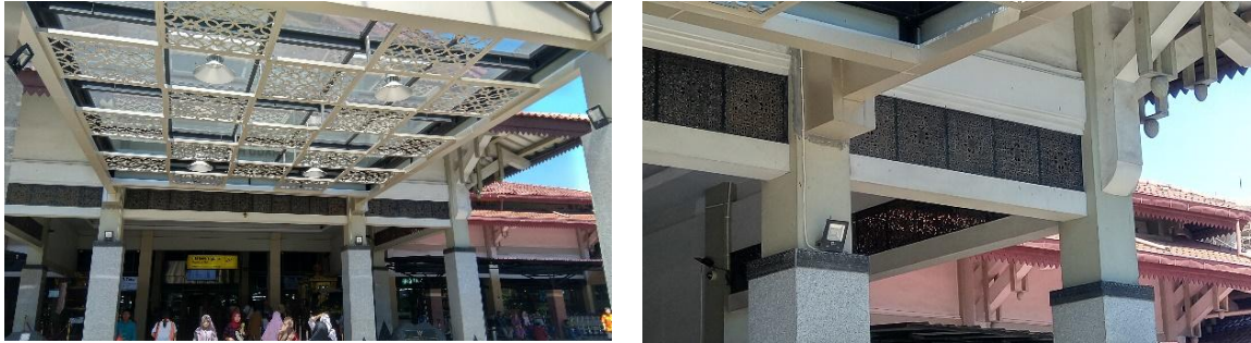
Gambar 14. Detail Ornamen Kanopi Sumber : Dokumentasi Lapangan, 2019
