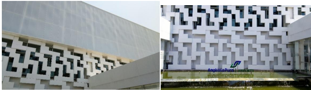
Gambar 3. Bentuk bangunan terminal Bandara Internasional Ahmad Yani Sumber : Dokumentasi Lapangan, 2019
