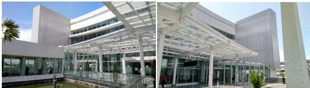
Gambar 4. Proporsi bangunan terminal Bandara Internasional Ahmad Yani Sumber : Dokumentasi Lapangan, 2019
