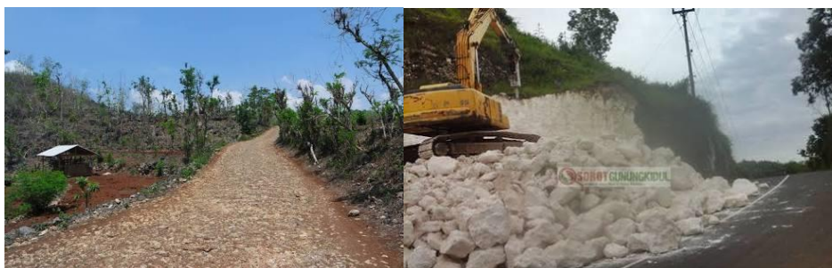
Gambar 4. Atas : Kondisi jalan bawah : proses pemotongan bukit Sumber : sorotgunungkidul.com dan eanindya.com
