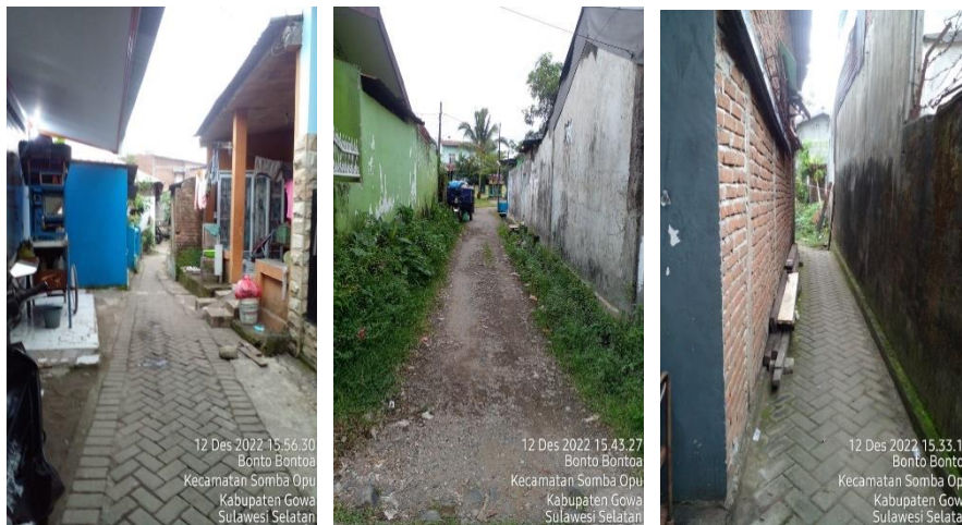
Gambar 2. Kondisi jaringan jalan di RT 1 RW 3 dan RT 2 RW 3 Kelurahan Bonto-Bontoa Sumber: Hasil Survey Tahun 2022
