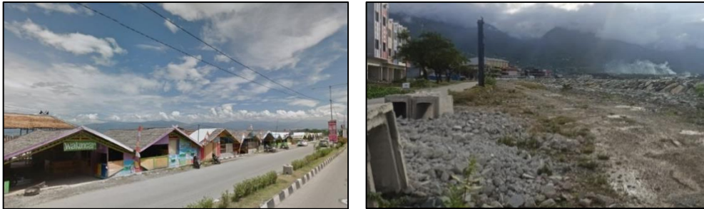
Gambar 3 Kawasan peruntukan sektor informal sebelum dan sesudah bencana Sumber : Google street view tahun 2017 dan dokumentasi lapangan 2023
