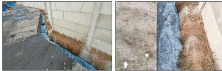
Gambar 8. Kondisi Sistem Drainase
