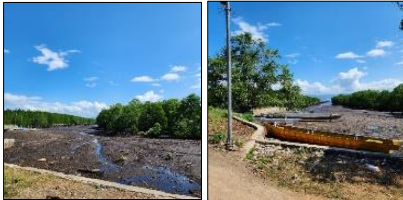
Gambar 6. Gambaran Kegiatan Pembangunan Fasilitas Tracking Mangrove Sumber: Dokumentasi Lapangan, 2023
