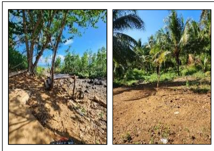
Gambar 4. Gambaran Kegiatan Pembangunan Dermaga Wisata Sumber: Dokumentasi Lapangan, 2023
