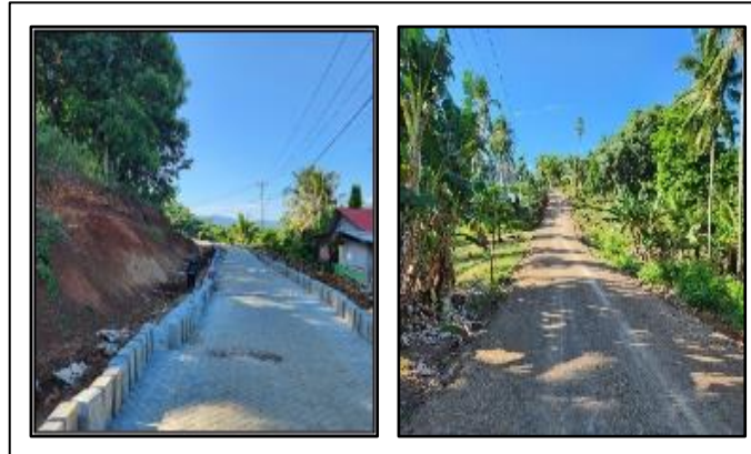
Gambar 2. Gambaran Kegiatan Peningkatan Jalan Poros Sumber: Dokumentasi Lapangan, 2023
