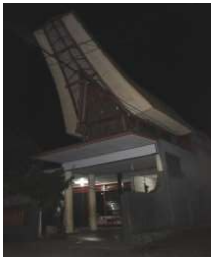
Gambar 12. Rumah yang telah terdistorsi ( Sumber ; data pribadi 2016 )
