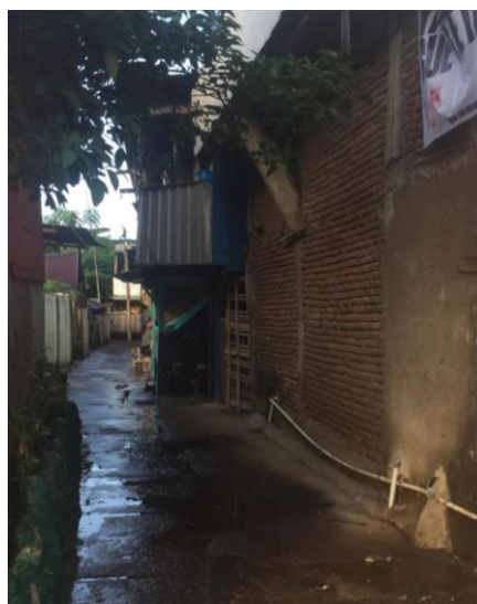
Gambar 3. Kondisi drainase lingkungan (Sumber: Hasil survey lapangan, Juni 2020)
