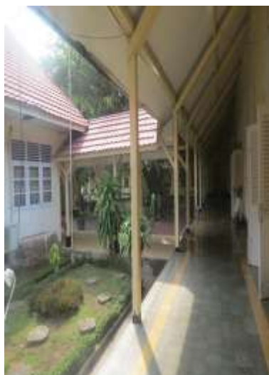
Gambar: Tiang Gedung Mulo Sumber: Hasil Survei di Gedung Mulo, 2017
