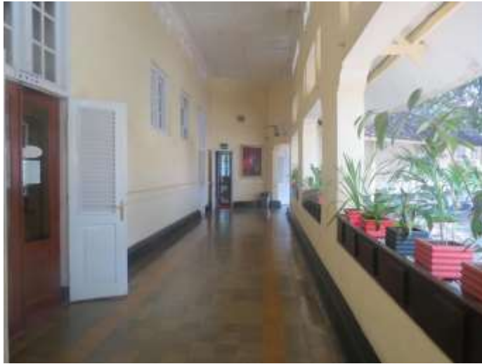
Gambar: Plafon Gedung Mulo Sumber: Hasil Survei di Gedung Mulo, 2017
