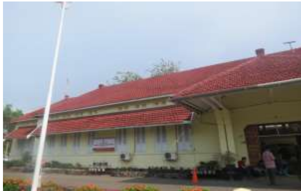
Gambar: Atap Gedung Mulo Sumber: Hasil Survei di Gedung Mulo, 2017
