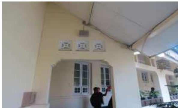
Gambar: Ventilasi Gedung Mulo Sumber: Hasil Survei di Gedung Mulo, 2017
