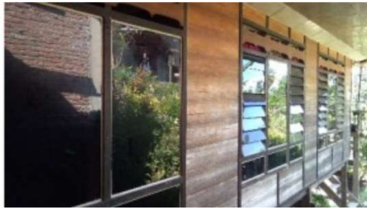
Gambar 20. Jendela pada bangunan Sumber: Dokumentasi Pribadi, 2020
