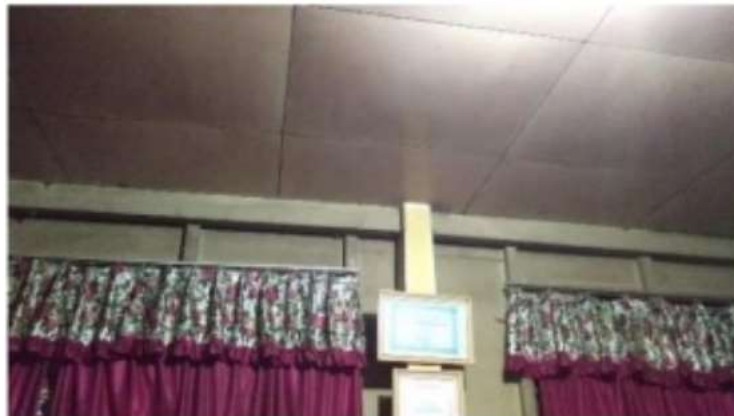
Gambar 21. Plafond pada bangunan Sumber: Dokumentasi Pribadi, 2020
