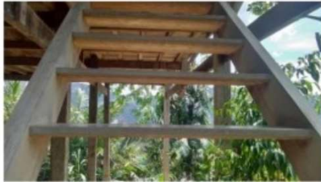
Gambar 17. Tangga Bangunan Sumber: Dokumentasi Pribadi, 2020
