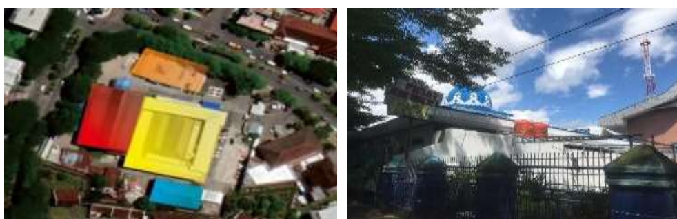
Gambar 1. Tata Massa bangunan dan tampak masjid di depan bangunan Sumber: Penulis, 2022
