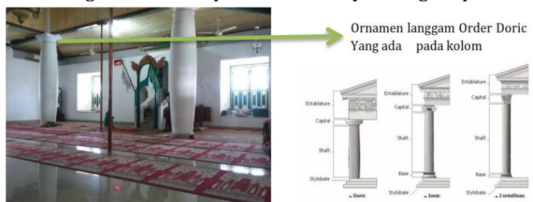
Gambar 4. Kolom/ Pilar Bangunan Mesjid Sumber: Hasil Survey 2019
