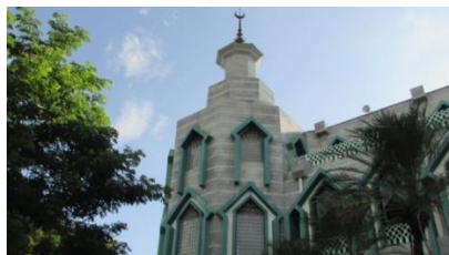
Gambar 6. Menara yang masing-masing berada di sisi bangunan masjid. Sumber: Dokumentasi Pribadi.
