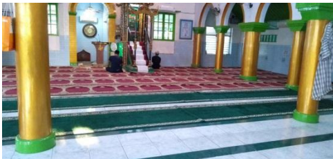
Gambar 10. Kolom Bangunan Tambahan Masjid Sumber : Hasil Survey, 2019
