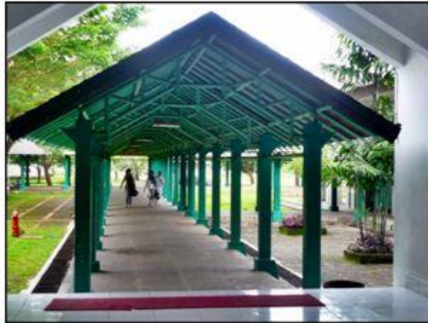
Gambar 7. Koridor Masjid Al-Markaz Sumber : Dokumentasi Pribadi, 2019
