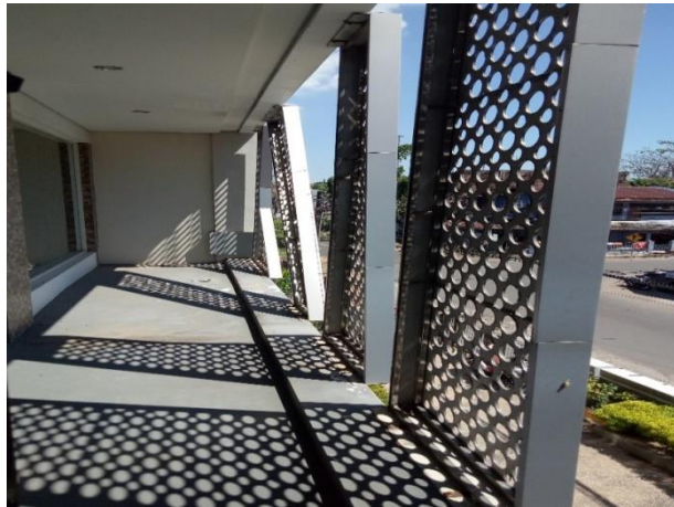
Gambar 5. Jendela di Lantai 2 (Dokumentasi Pribadi)
