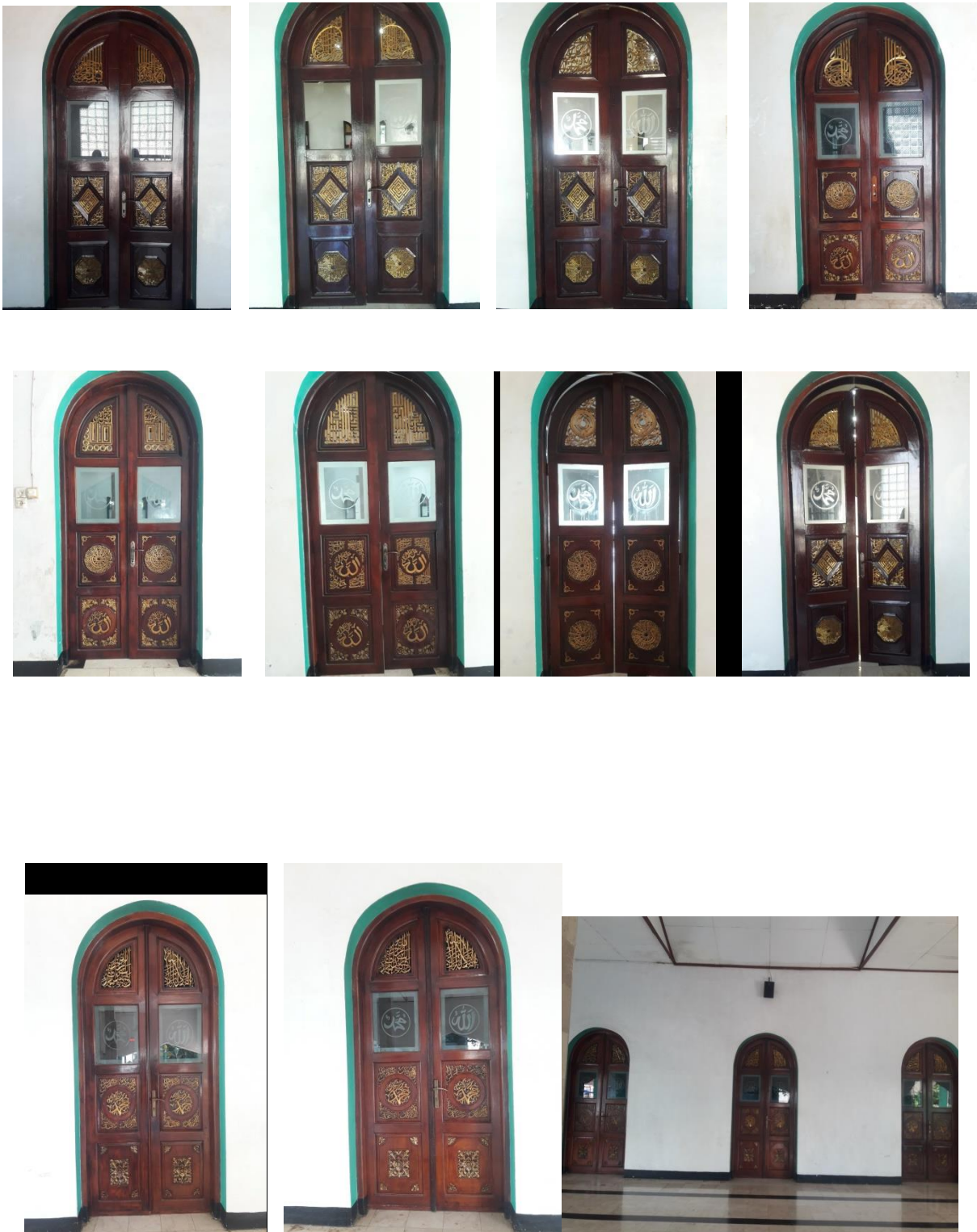
Gambar 1. Jenis Pintu Masjid Sumber : Survey Lapangan 2019
